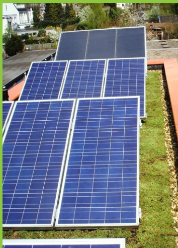
Groendak in combinatie met zonnepanelen
