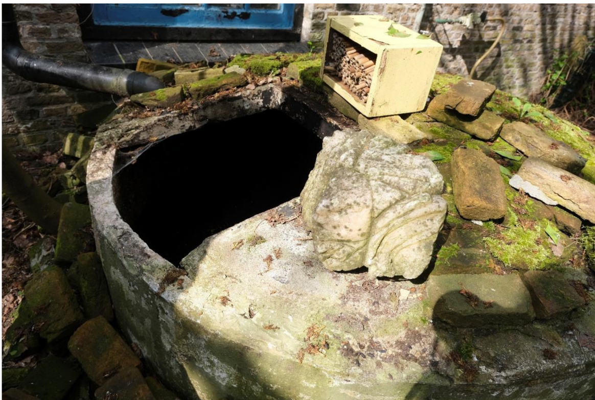
Afbeelding 28 Aan de voorzijde van de molenaarswoning bevindt zich een betonnen wateropslag voor regenwater. Foto Vestigia 23-03-2023.
