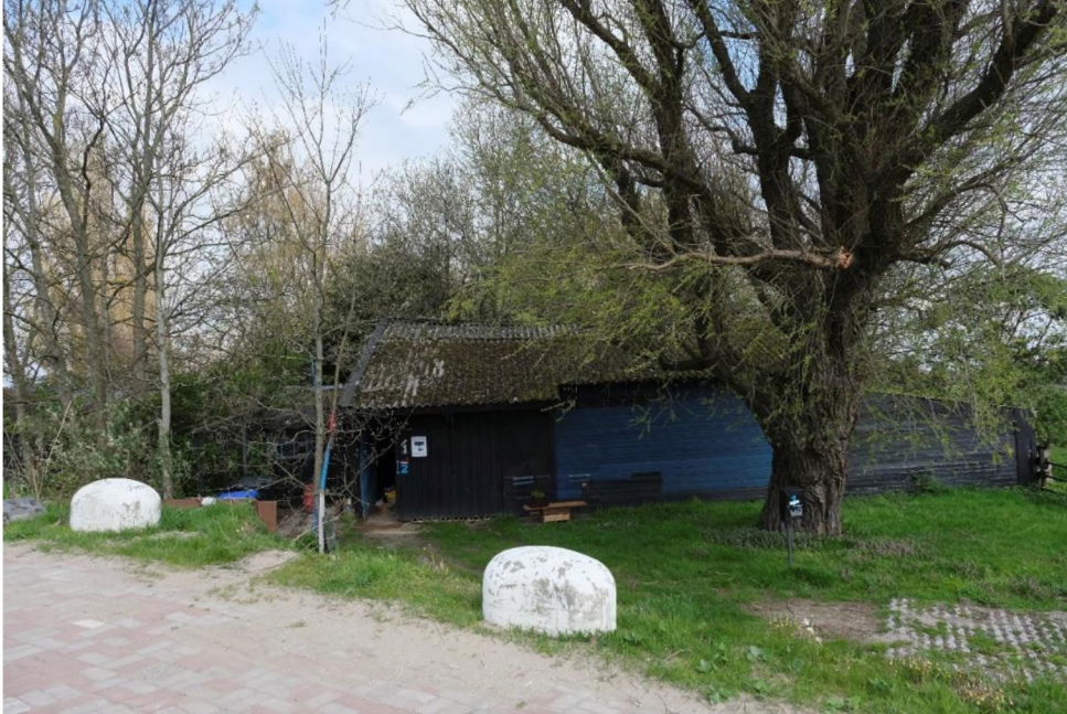
Afbeelding 24 Het blauw met zwart geschilderd atelier met golfplaten dak en diverse aanbouwen staat dwars op de ingang tot het erf van de molenaarswoning. Foto Vestigia 23-03-2023.
