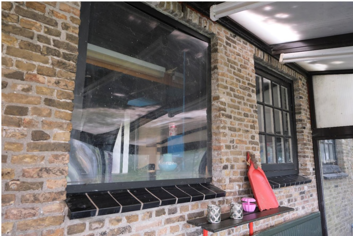
Afbeelding 17 Achtergevel (nu binnenmuur): Deels gewijzigde vensters en kozijnen, vernieuwd voegwerk. Foto Vestigia.
