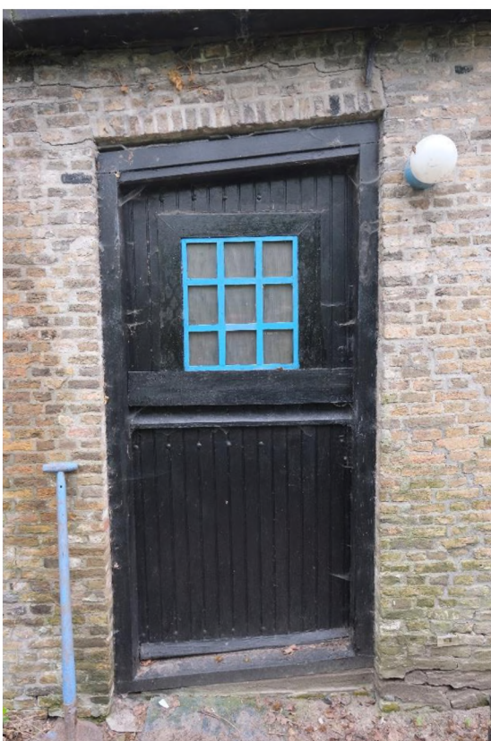
Afbeelding 16 (onder) Links het sterk aan de verzakking aangepaste kozijn van de voordeur; rechts het 16-ruits venster met vernieuwde dorpel. Foto's Vestigia 23-03-2023.
