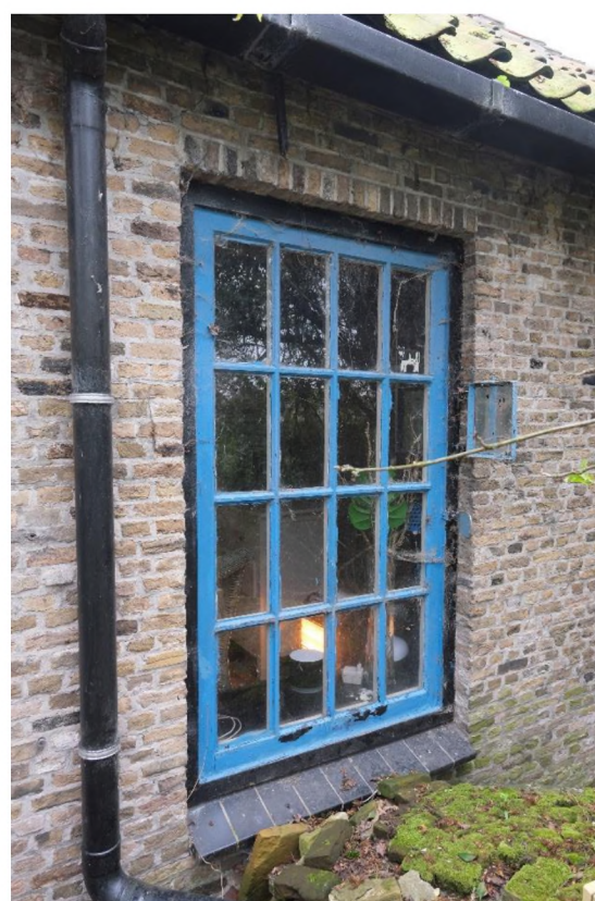
Afbeelding 16 (onder) Links het sterk aan de verzakking aangepaste kozijn van de voordeur; rechts het 16-ruits venster met vernieuwde dorpel. Foto's Vestigia 23-03-2023.
