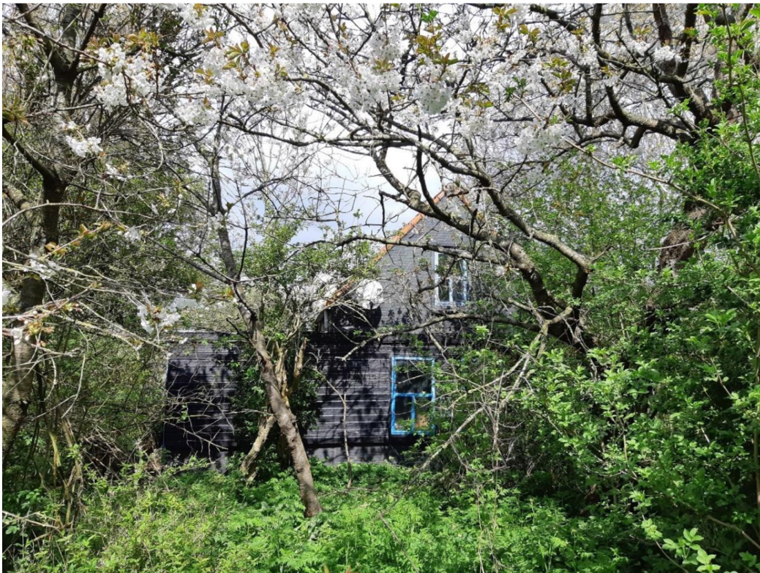
Afbeelding 19 De zuidgevel van de zwart geschilderde aanbouw. Foto Vestigia 23-03-2023.
