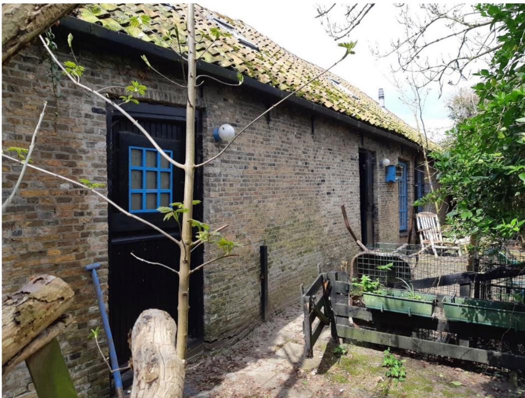
Afbeelding 15 De voorgevel van het oorspronkelijke deel van de molenaarswoning. Foto Vestigia 23-03-2023.
