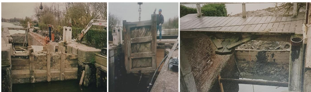
Figuur 11. Foto's uit 1992 die het functioneren van verschillende onderdelen van een schutsluis weergeven. Links zijn de dubbele schotbalken bij het bovenhoofd zichtbaar met daartussen klei om de sluis waterdicht af te sluiten voor de werkzaamheden. In het midden wordt er een puntdeur uit getakeld aan het oog bovenop de deur en rechts is de schotbalk bij het benedenhoofd zichtbaar. (Bron: (5.1)(2)(e)).
