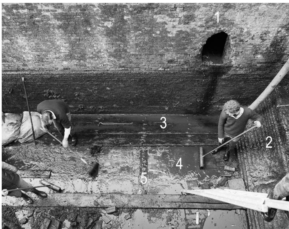
Figuur 23. Zicht op de bodem van de sluisolk bij het bovenhoofd tijdens werkzaamheden in 1984 met kenmerkende onderdelen. 1. Opening van het omloopriool. 2. Stenen stortmuur. 3. Houten bovenvloer. 4. Bakstenen opvulling tussen de kessen. 5. Kessen (Bron: RCE 248227).
