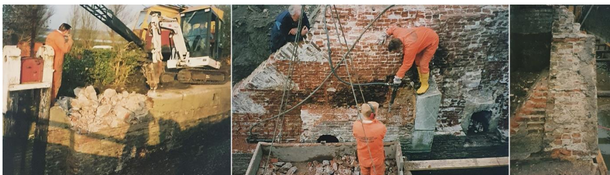
Figuur 24. Sloop van de oorspronkelijke schil in 1992. Links werd de betonnen afdekrand verwijderd. In het midden werd de bakstenen schil bij het benedenhoofd verwijderd en rechts was een doorsnede van de muur met steunberen van de sluiscolk zichtbaar geworden tijdens de sloop (Bron: (5.1)(2)(e)).
