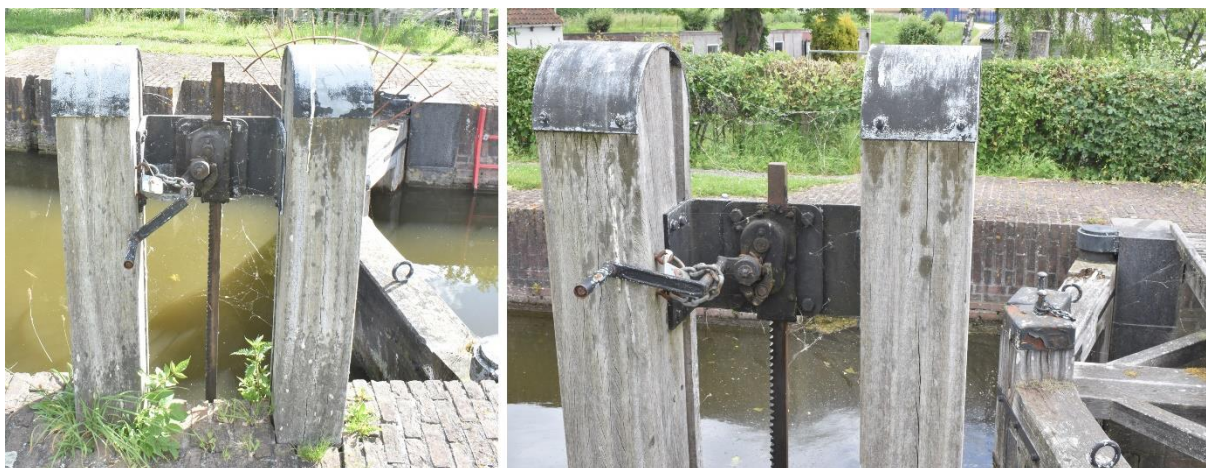
Figuur 16. Bewegingsmechanismes van het boven- (links) en benedenhoofd (rechts) (foto's: RAAP).
