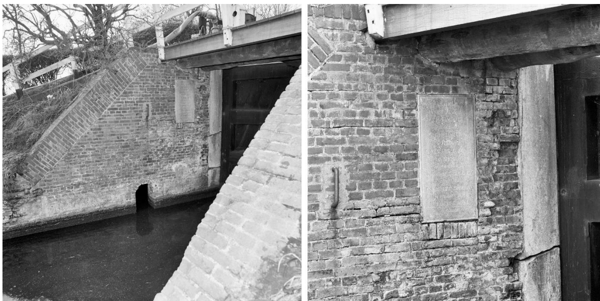
Figuur 21. Foto's uit 1984 met de toenmalige situatie van de westelijke vleugelmuur bij het benedenhoofd (Bron: 248222/248232). Op de rechterfoto is een detail te zien van de oorspronkelijke gevelsteen uit 1862 maar nu nog op de westelijke vleugelmuur in plaats van op de oostelijke vleugelmuur. Deze situatie heeft geduurd tot de reconstructie in 1992.
