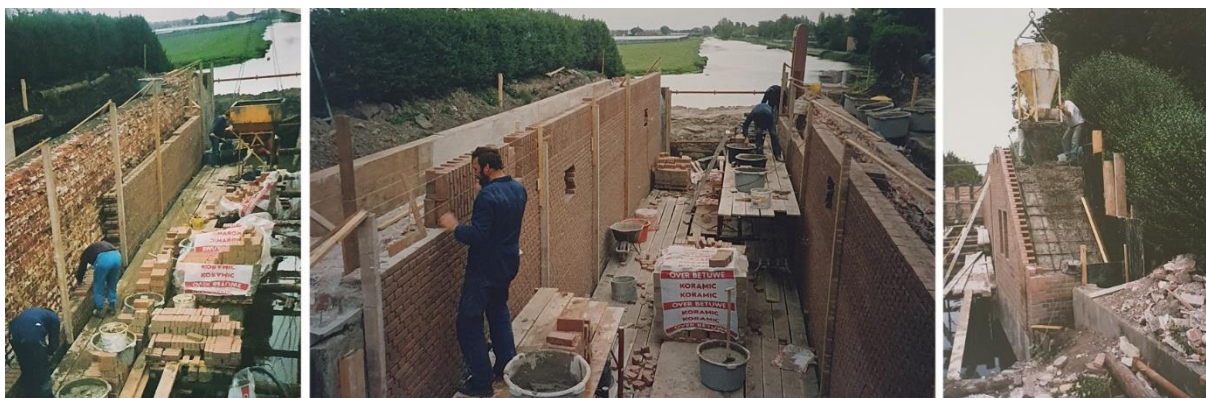
Figuur 25. Reconstructie van de sluiscolk in 1992. Nadat de buitenste laag was verwijderd heeft men een nieuwe bakstenen schil aangebracht. De ruimte tussen de nieuwe schil en het restant van de oorspronkelijke muur werd volgestort met beton (Bron: (5.1)(2)(e)).
