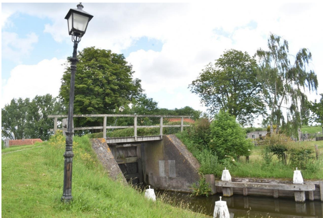
Figuur 18. Overzicht van de schutsluis vanuit het zuidwesten met zicht op de het benedenhoofd met bruggetje en de vleugelmuren met daarvoor afremwerk (foto's: RAAP).
