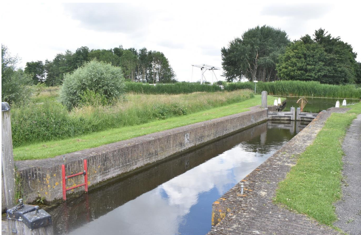
Figuur 22. Overzicht van de sluisolk gezien vanuit het westen (foto: RAAP).
