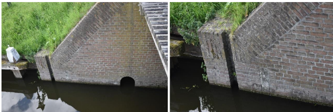
Figuur 19. De westvleugel bij het benedenhoofd met op de linker foto de opening van het omloopriool. Op de rechter foto een detail met de sponning voor de schotbalk (foto's: RAAP).
