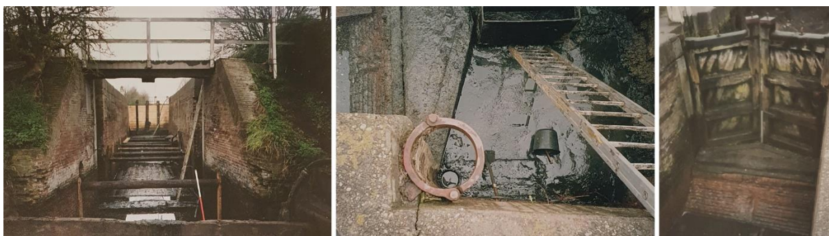
Figuur 10. Foto's uit 1992 tijdens de werkzaamheden, de puntdeuren zijn al verwijderd en de schutkolk is leeggepompt. Links een overzicht vanuit het zuiden. In het midden is de houten komplaat voor een puntdeur zichtbaar onder de halsbeugel op de bodem van de sluis. Rechts is de stenen stortmuur te zien. (Bron: (5.1)(2)(e))
