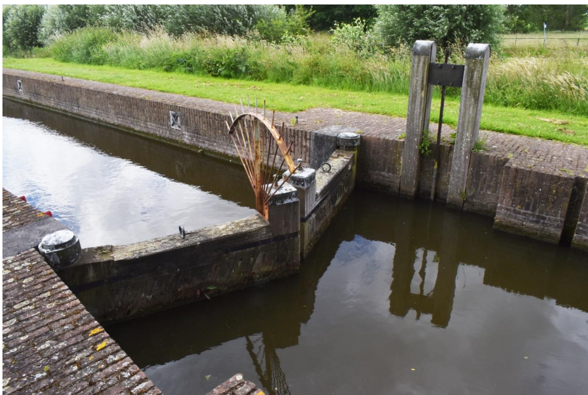
Figuur 14. Bovenhoofd gefotografeerd vanuit het noorden met links de puntdeuren en rechts daarvan het bewegingsmechanisme van het omloopriool (foto's: RAAP).
