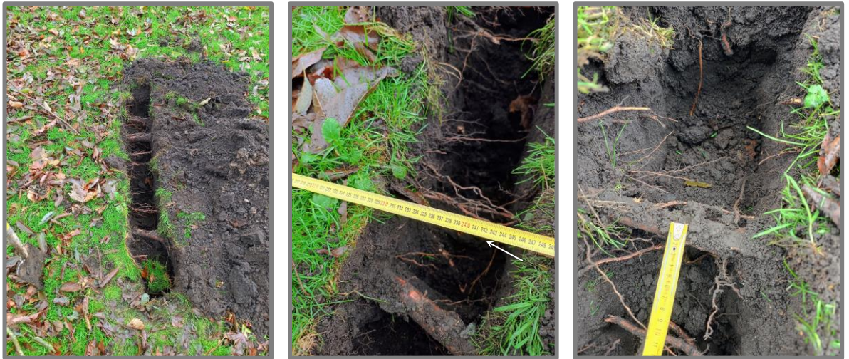
Fig. 7: Proefsleuf bij bomen 16 en 17: De proefsleuf bij boomnummer 16 en 17 laat een hoge grondwaterstand zijn welke momenteel op 40 cm onder maaiveld ligt. De aangetroffen beworteling bevindt zich allemaal in de bovenste 20 cm. Door bereiding of onzorgvuldig graven kan er snel omvangrijke wortelschade aan de kluiten ontstaan waardoor de bomen gevoeliger worden voor windworp of in conditie sterk achteruit kunnen lopen.
