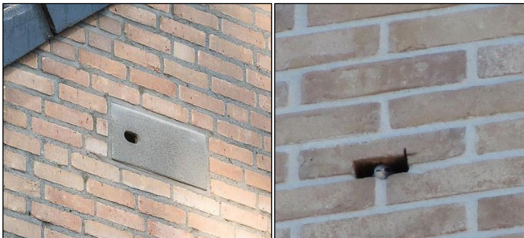
Figuur 3: InmetSELstenen zichtbaar (links) en onzichtbaar (rechts) in de gevel verwerkt (bron: Vivarapro).
