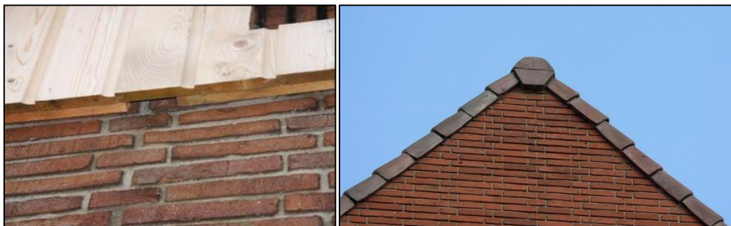
Figuur 2: Voorbeeld van toegankelijke boeiboorden (links) en nokvorst (rechts) (Bron: bouwnatuurinclusief).
