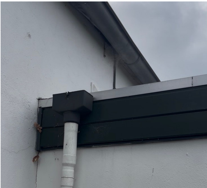
Foto regenwaterafvoer huisnummer 342
