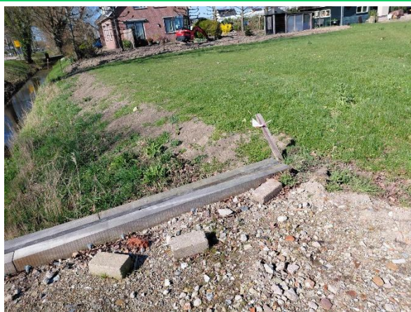
Foto 3: Overzichtsfoto met puin waarneming, genomen vanaf de dam richting het westen.
